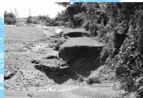
黒川堤防（福和田地内）
