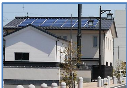
太陽光パネル（現防災センター）
