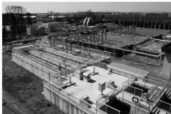
水処理センター
