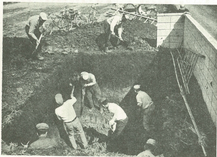
防火槽の作業風景 (藤井台坪)
