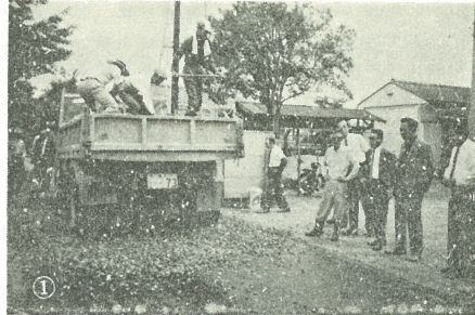
舗装道路工事
